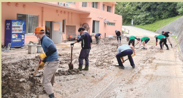
▲土砂撤去作業中
