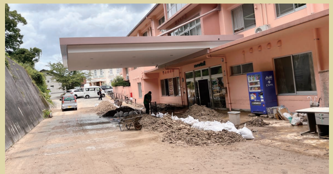
▲土砂撤去作業後
